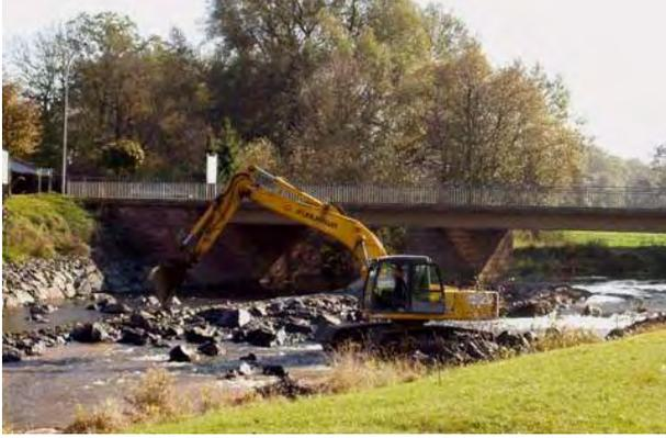
**Abb. 15: Bau einer rauen Rampe am Ortsrand von Buttlar**
