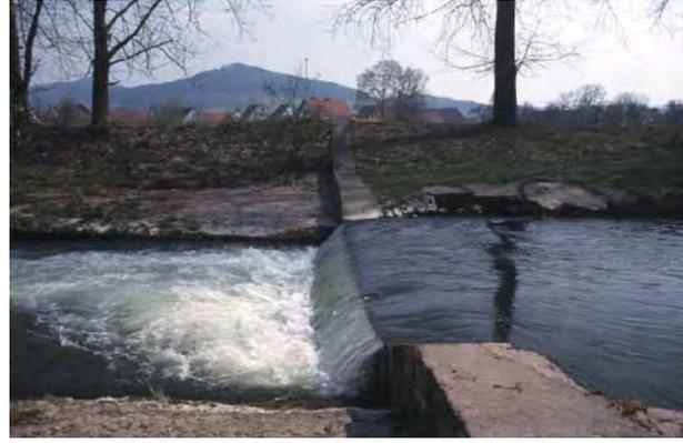
**Abb. 16: ehemalige Sohlschwelle in der Ulster bei Buttlar**
