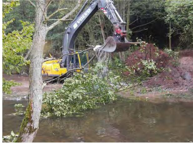
**Abb. 9: Einbau von Totholz zur Redynamisierung der Ulster im Bereich der Ausleitungsstrecke**
