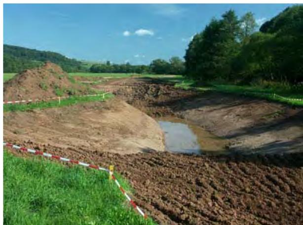
**Abb. 6: Unterer Abschnitt des neu angelegten Ulster-Armes nach Abschluss der Erdarbeiten**
