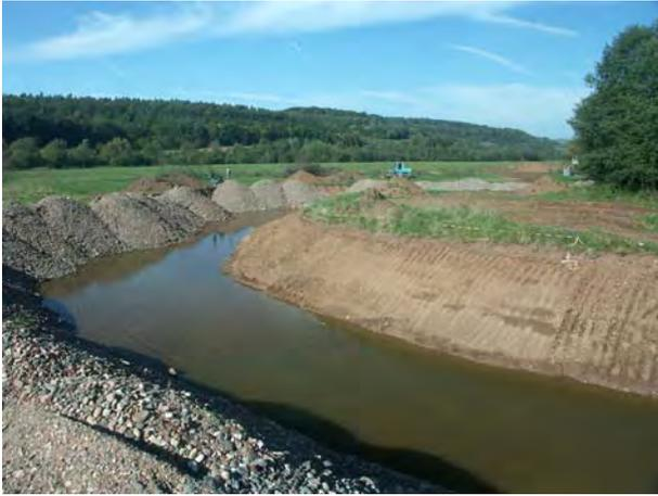
**Abb. 8: Flusskies-Schüttung als Ausgangsmaterial für eine naturnahe eigendynamische Gewässer-gestaltung**
