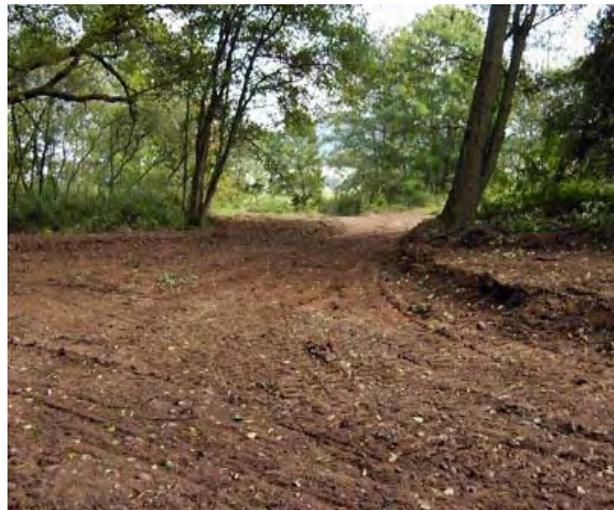
**Abb. 11: Wiederherstellung eines Überflutungsbereichs im ehemaligen Ulsterbett bei Schleid – gedacht als Initiale für eine weitere Ausformung durch Hochwässer**
