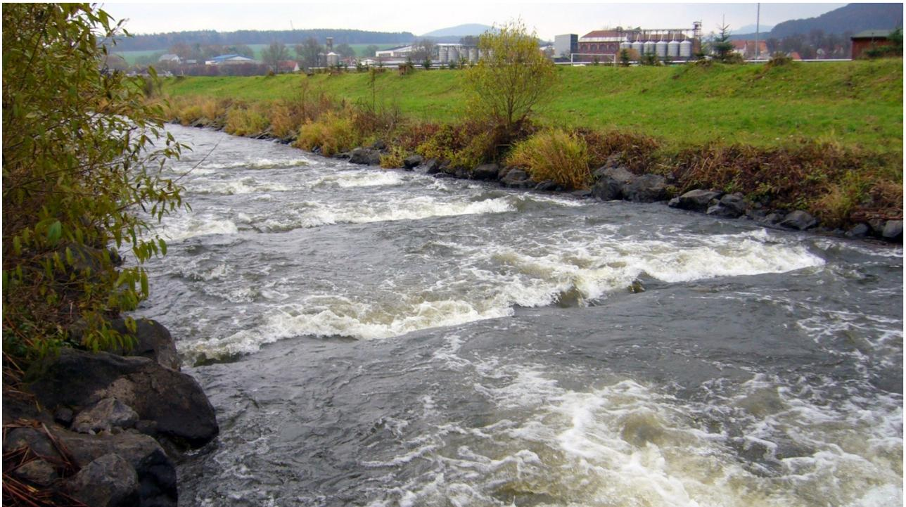
**Abbildung 7:** mäßige Gewässerstruktur nördlich von Buttlar mit Uferverbau, Begradigung und Sohlschwellen
